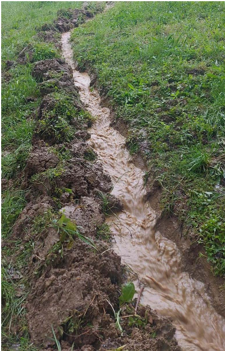
Slika 6: ročno skopan jarek nad plazom za preusmeritev vode iz vinograda v času padavin (posnetek je nastal dne 17. 05. 2023)
