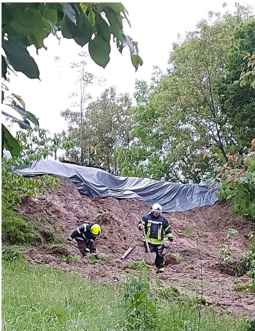
Slika 3: Plaz med prekrivanjem s folijo (16. 05. 2023)
