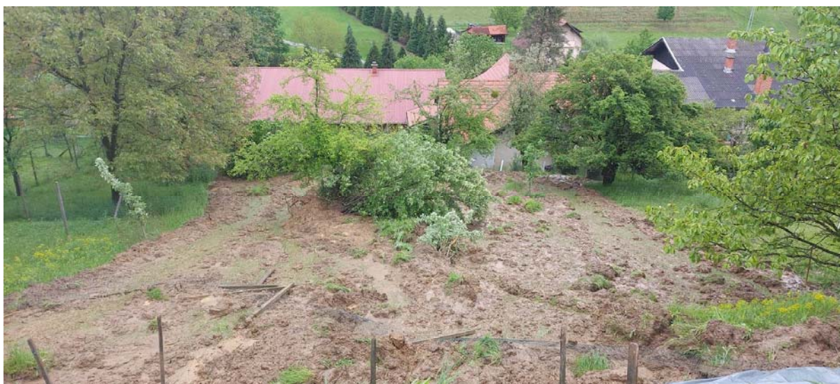
Slika 2: pogled od plazu proti objektom
